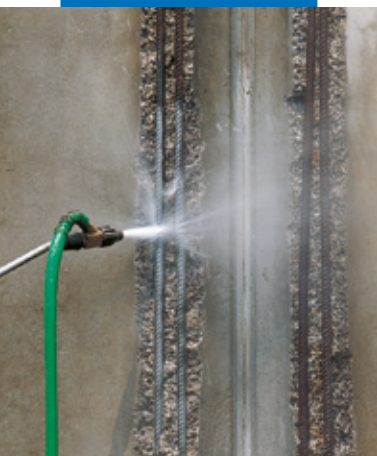
Pulizia dei ferri con idrosabbatura
