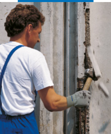
Demolizione del calcestruzzo degradato
