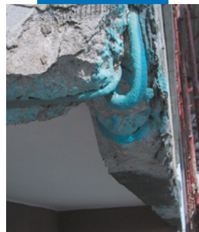
Ferri di armatura del frontalino di un balcone trattati con Mapefer 1K
