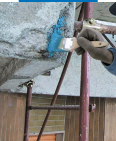
Applicazione a pennello di Mapefer 1K sui ferri di armatura di un balcone in calcestruzzo armato
